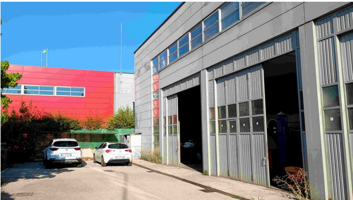
Foto ingressi deposito comunale e laboratorio (sopralluogo del 5 agosto 2025)
