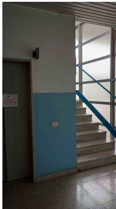
Foto vano scala ed ascensore (sopralluogo del 5 agosto 2025)
