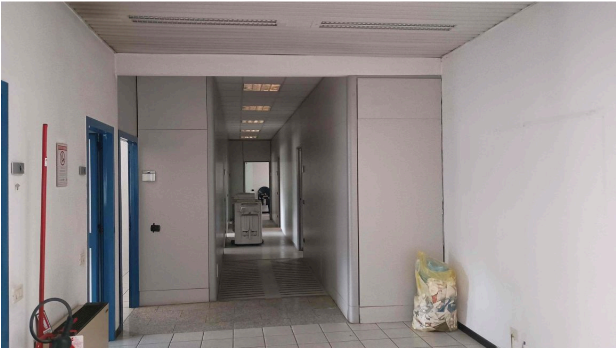
Foto corridoio ufficio con divisori interni e caratteristiche costruttive (sopralluogo del 5 agosto 2025)
